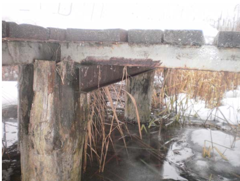
Skorodowana konstrukcja stalowa
